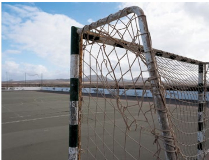
Estado actual de la cancha deportiva.
