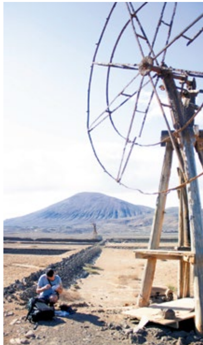
Pozo de las Salinas de Los Agujeros, cerca de Los Cocoteros, uno de los ejemplos que quedan de cómo las salinas de Lanzarote utilizaban tradicionalmente agua subterránea salina para producir sal. A través de estos pozos todavía se puede acceder a fauna subterránea endémica.
