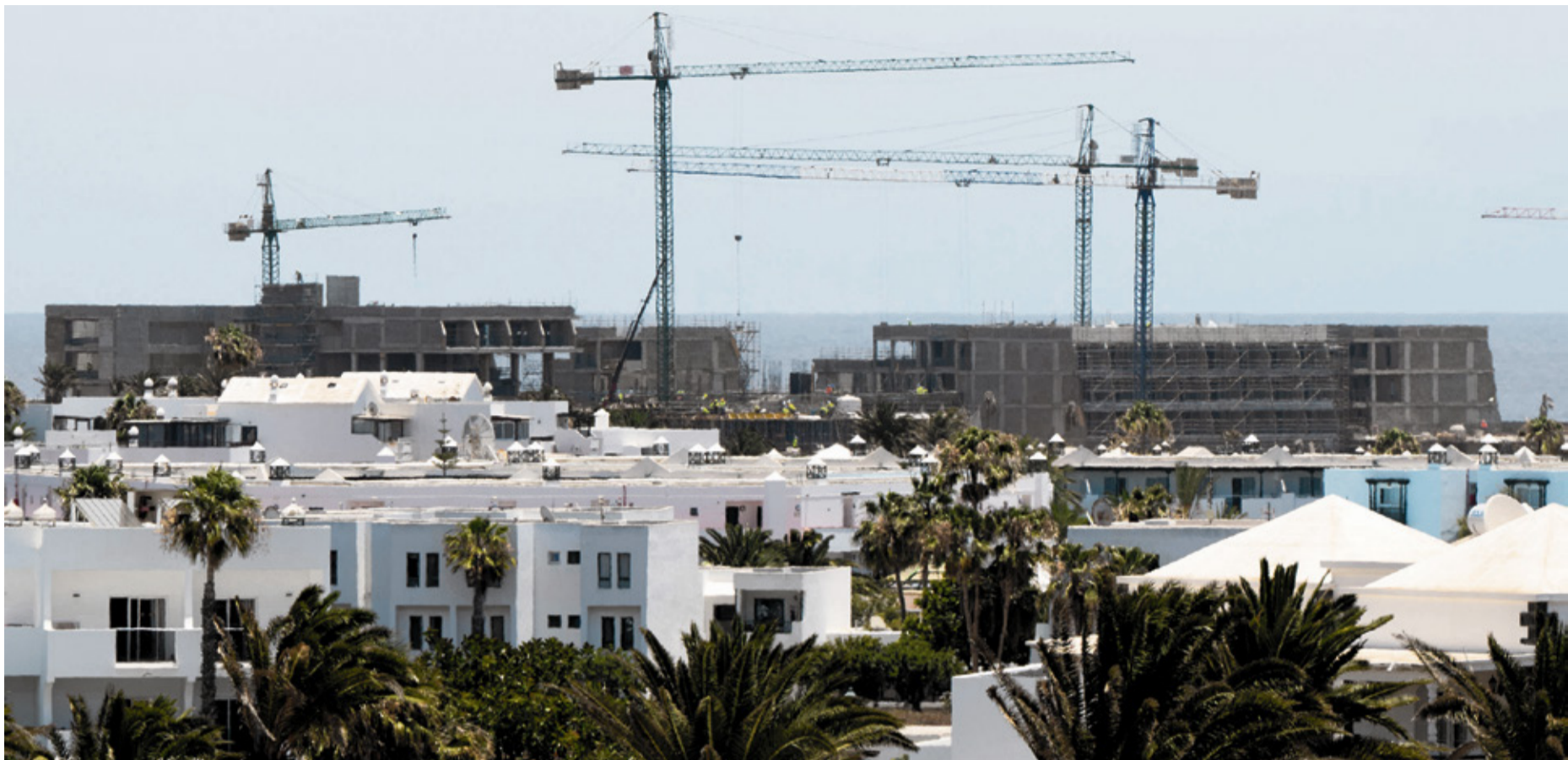
Hotel en construcción en Costa Teguise. Fotos: Adriél Perdomo.
