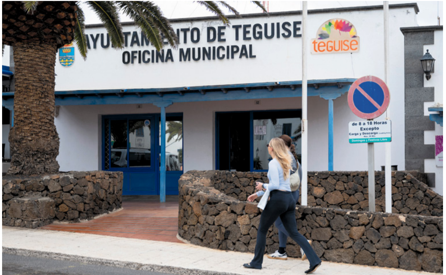
Instalaciones de la Oficina Técnica en Costa Teguisse. Fotos: Adriel Perdomo.
