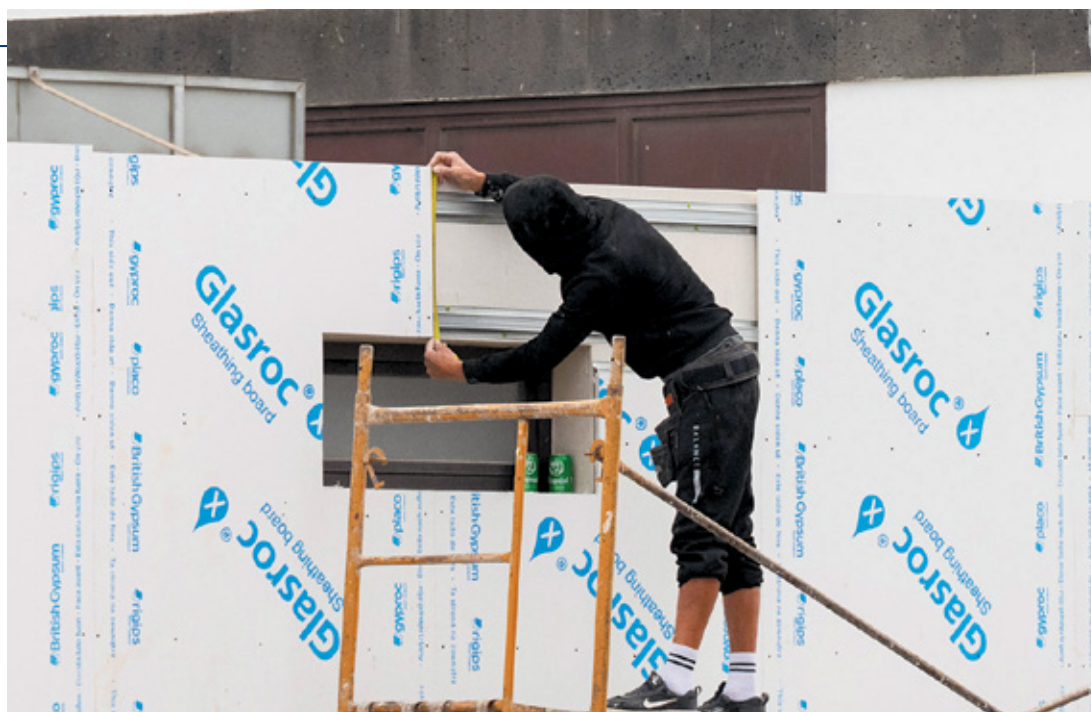
Trabajador en una obra en Arrecife.
