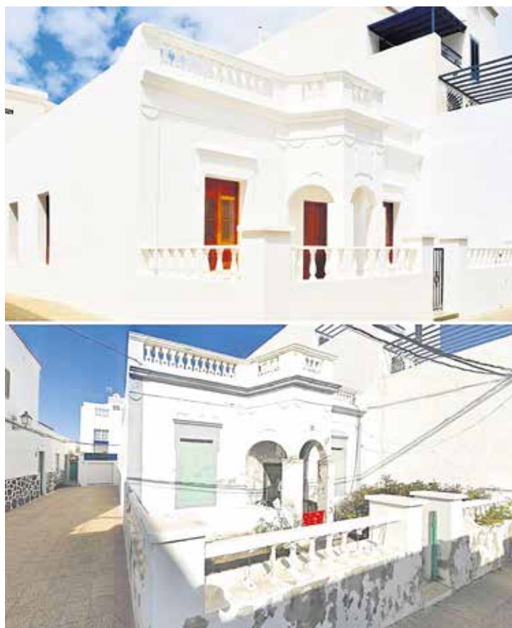
Arriba, la vivienda en la actualidad y abajo, la casa antes de la rehabilitación.
