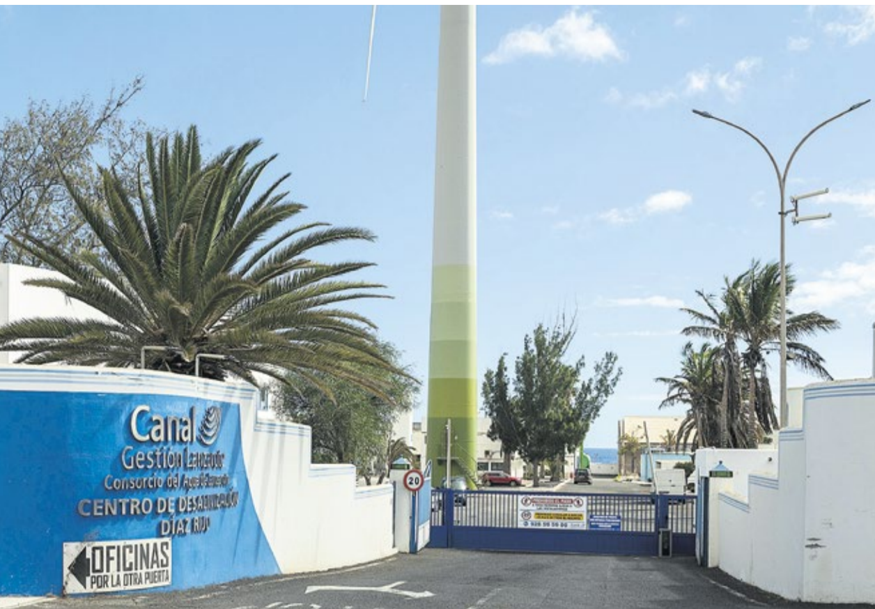
Central de desalación Díaz Rijo. Foto: Adriel Perdomo.
