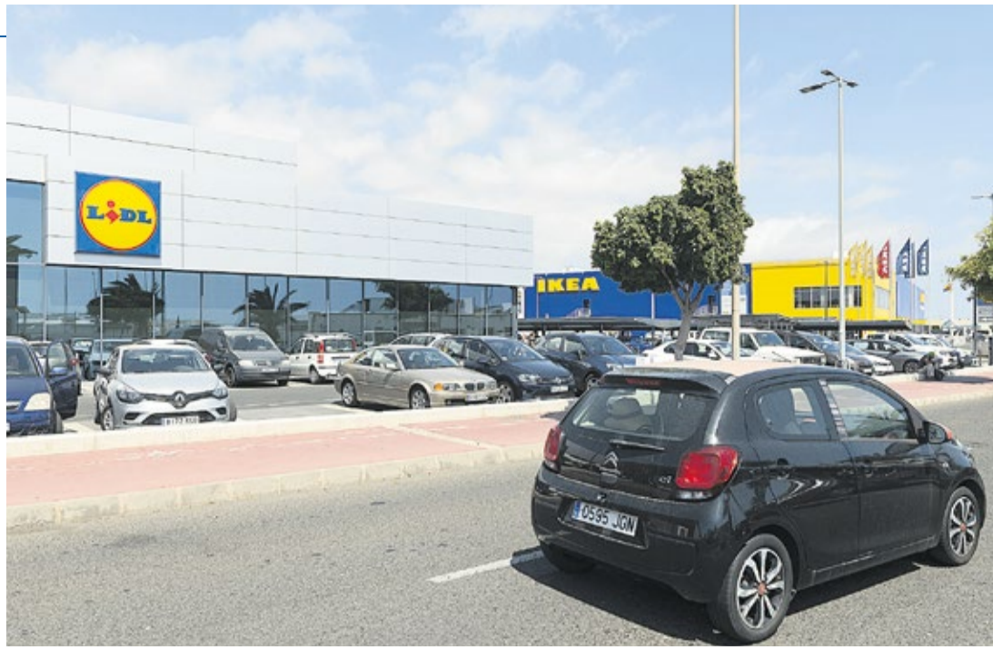
En el polígono de Ikea, el Consistorio va a tener que revisar de oficio la urbanización por sentencia judicial.
