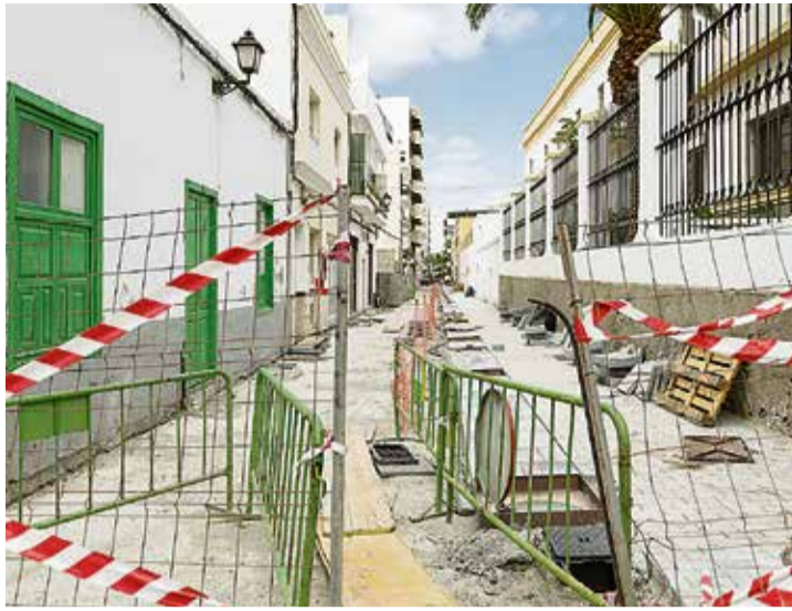
Obras en la calle Canalejas.
