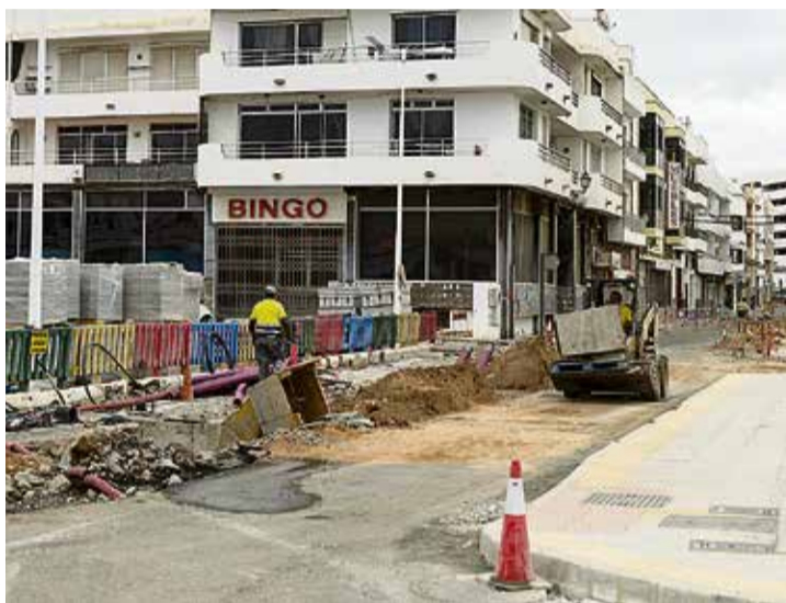
Trabajos en la calle Portugal.
