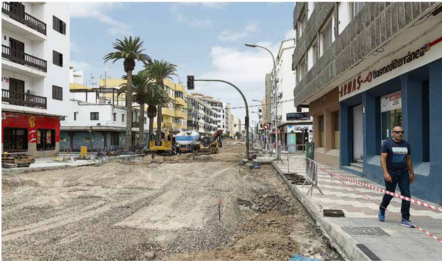
Obras en la calle Manolo Millares. Fotos: Adriel Perdomo.
