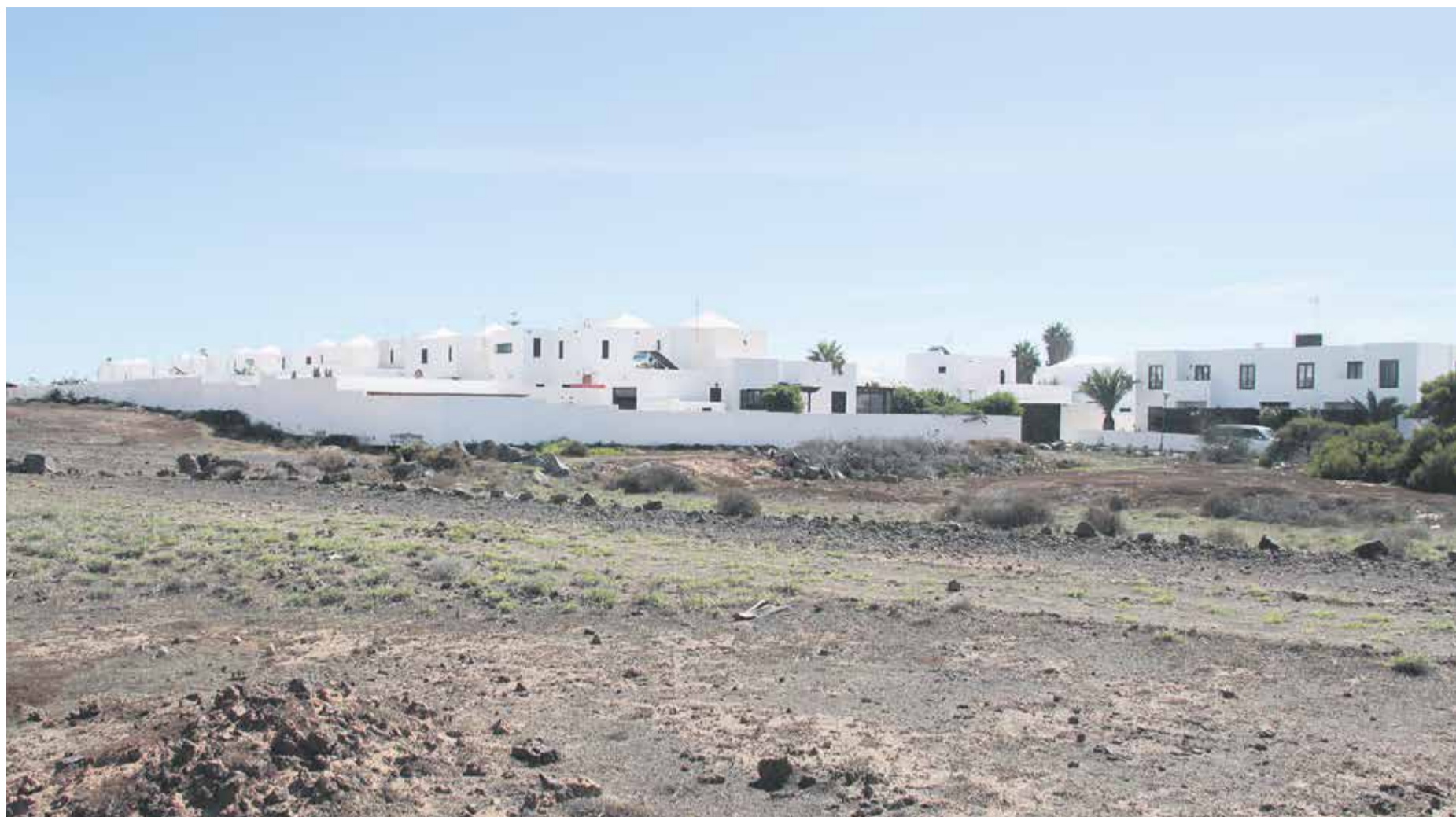
La urbanización invade suelo rústico de protección de jable. Fotos: DDL.
