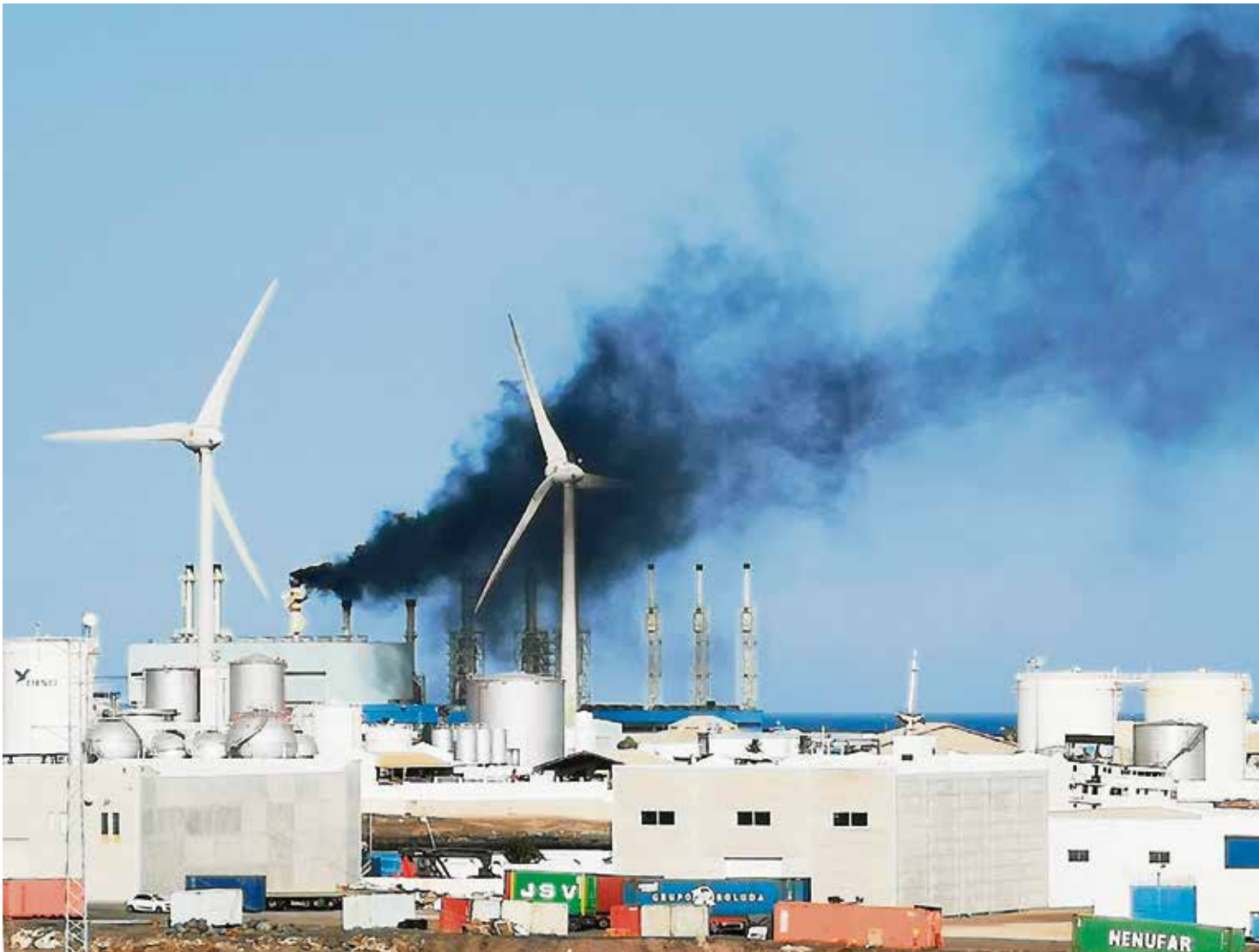
Central térmica de Endesa en Las Caletas. Foto: Rafael Fuentes.
